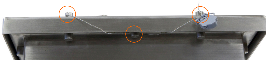
Figure 2-85 : Apposition des sceaux version Junction Box (mise à jour) – Goujon et vis de scellage
