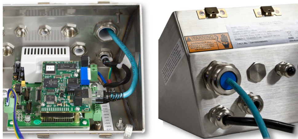
Figura 3-66: Colocación del cable Ethernet en el gabinete para ambientes adversos
