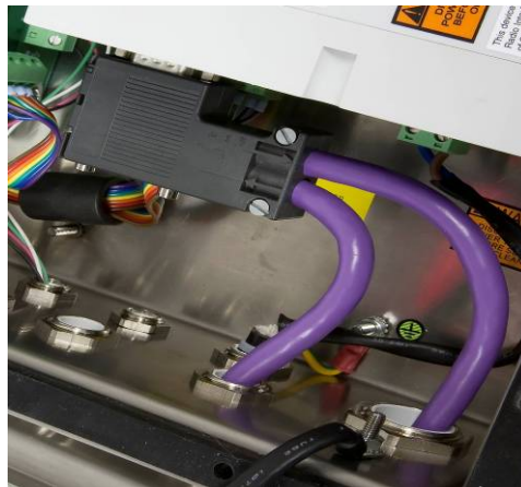
Abbildung 2-70: PROFIBUS-Kabelführung für das Abzweigkastengehäuse, Originalversion
