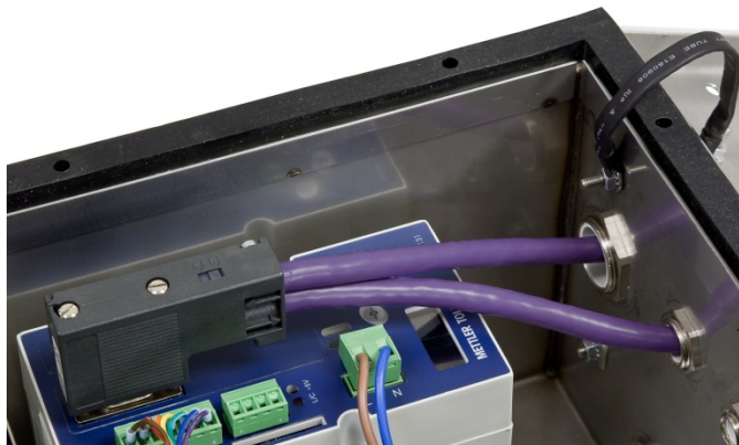
Figura 3-71: Colocación del cable PROFIBUS en el gabinete para caja de conexiones, versión actualizada
